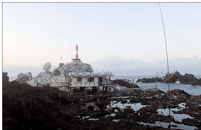
Blick auf einen Teil unserer Antennen auf dem Felsen Belmonte; vorn (mittig) sieht man die Schutzhütte und dahinter den kleinen Leuchtturm auf dem höchsten Punkt des Felsens.
