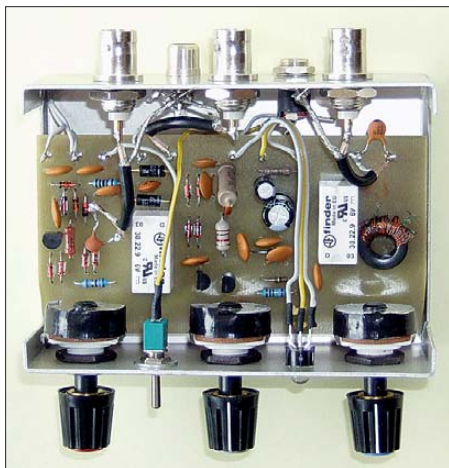
Bild 1: Ansicht der kompletten Verdrahtung in der X-Phase II
