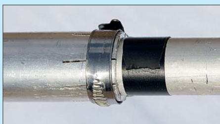
Bild 8: Nach dem Lösen der Schellen lassen sich die Elementabschnitte zum Abgleich ineinander schieben.
